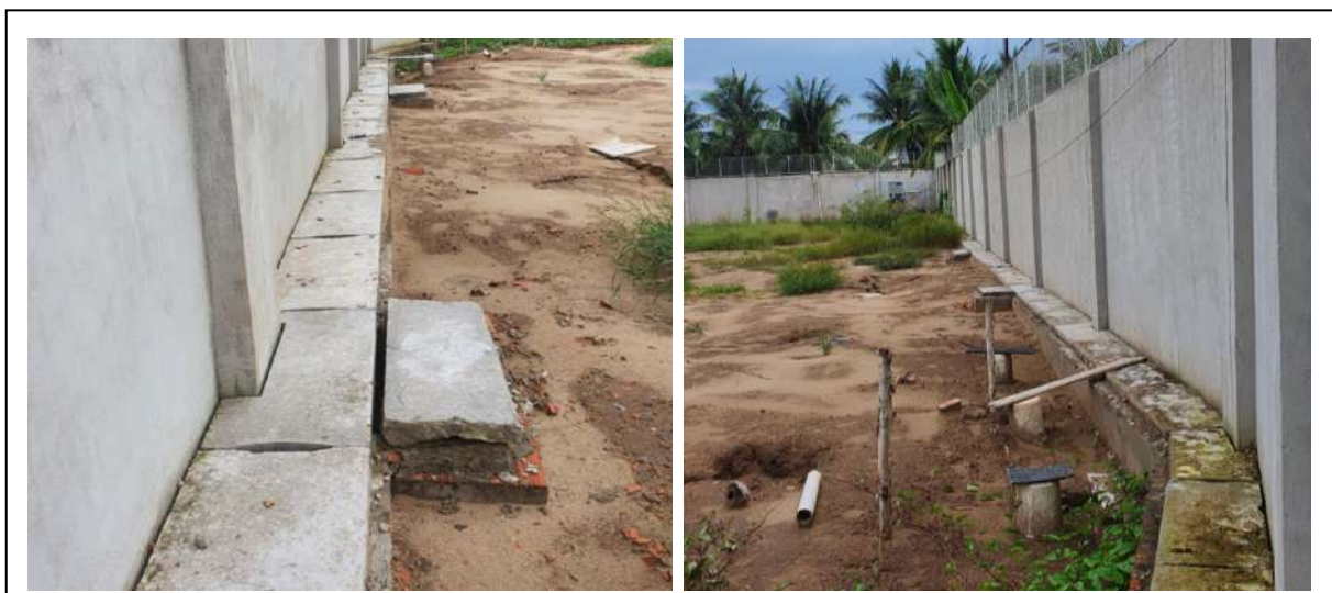
Hình 8. Hiện trạng tuyến cống thoát nước mưa và hố ga đã được xây dựng
